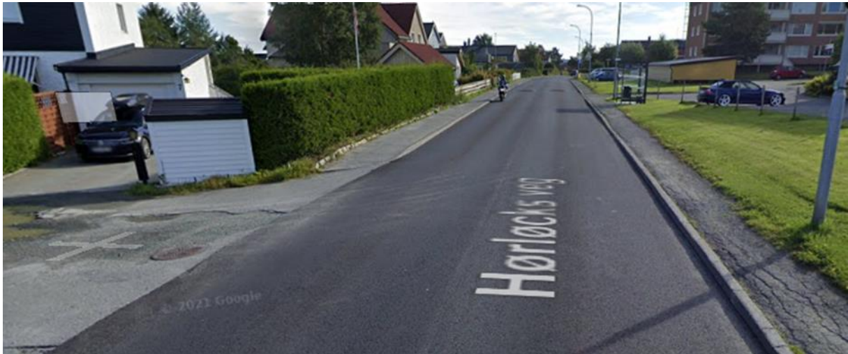
Figur 2: Gatebilde fra Hørløcks veg.
