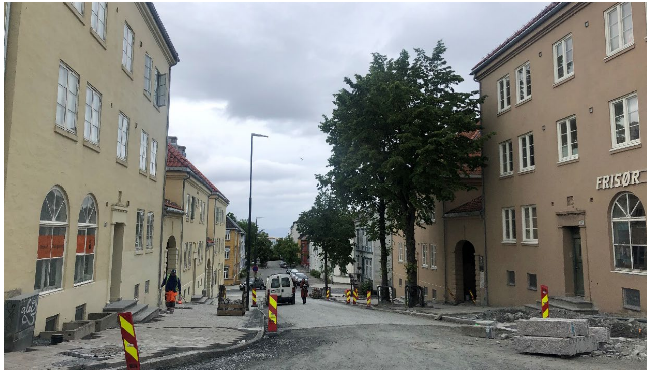
Figur 22 Strekningen sett fra krysset mot Haldens gate og nordover. Bilde: Asplan Viak
