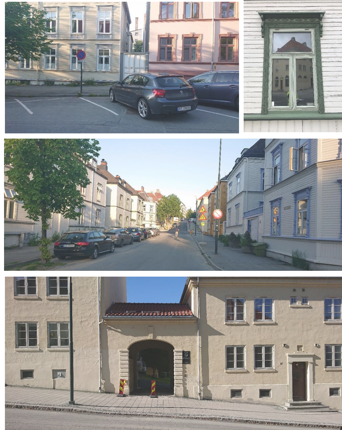
Figur 2 Fra toppen: Gyldenløves gate mellom Kirkegata og Nedre Møllenberg, detalj av vindu, gaten mellom Weidemanns vei og Båhus gate, detalj fra Sverre Pedersens murgårder fra 1920-tallet mellom Haldens og Båhus gate.
