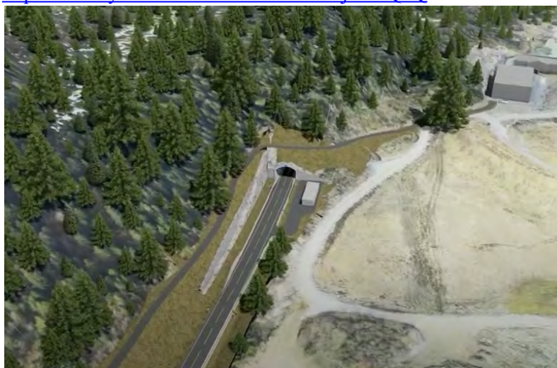
Figur 1: Tanemstunnelen. Søndre påhuggsområde.
