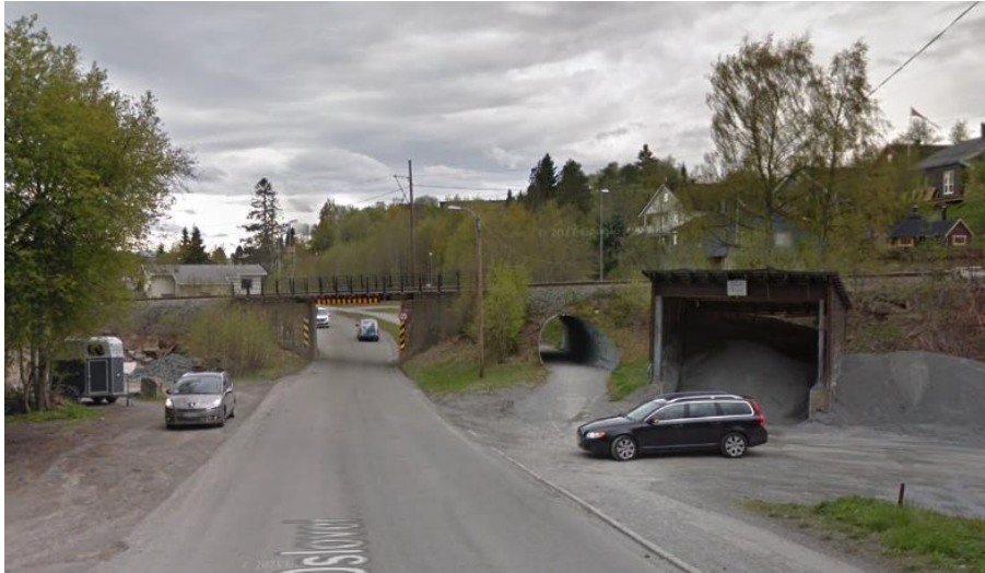
Figur 12: Dagens situasjon inn mot Ugla bru og kulvert for gang- og sykkelvegen. Til høyre i bildet ser vi deler av kommunens gruslager. Vegbanen innsnevres under brua og maks høyde er 3,8 m.
