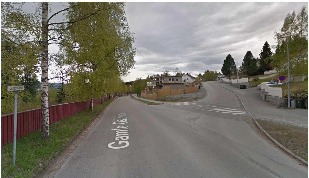
Figur 102: Bildet viser krysset ved Uglavegen som er noe utflytende
