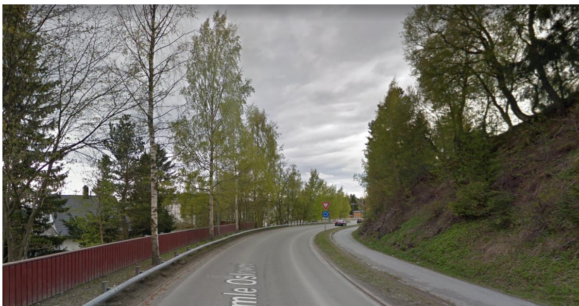
Figur 103: Bildet viser dagens løsning med gang- og sykkelveg, her er det høydeforskjeller mot bebyggelsen på venstre side og bratt terreng på høyre side
