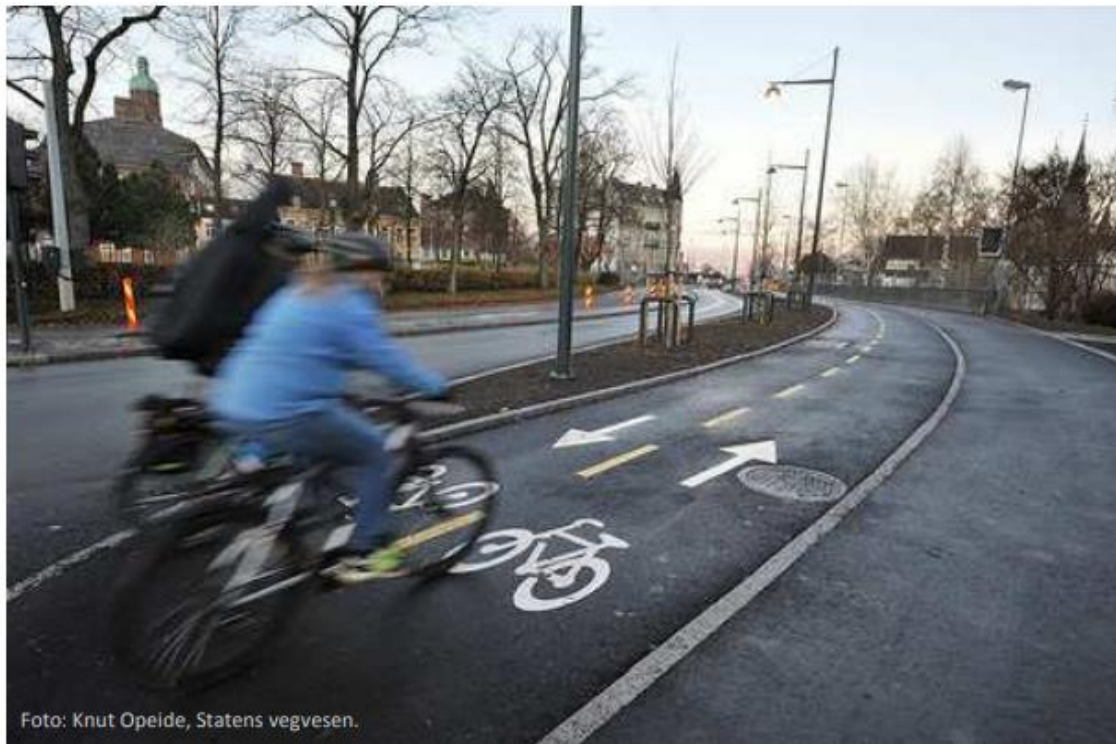
Figur 22: Bildet viser eksempel på sykkelveg med fortau langs Søndre Ilevollen i Trondheim
