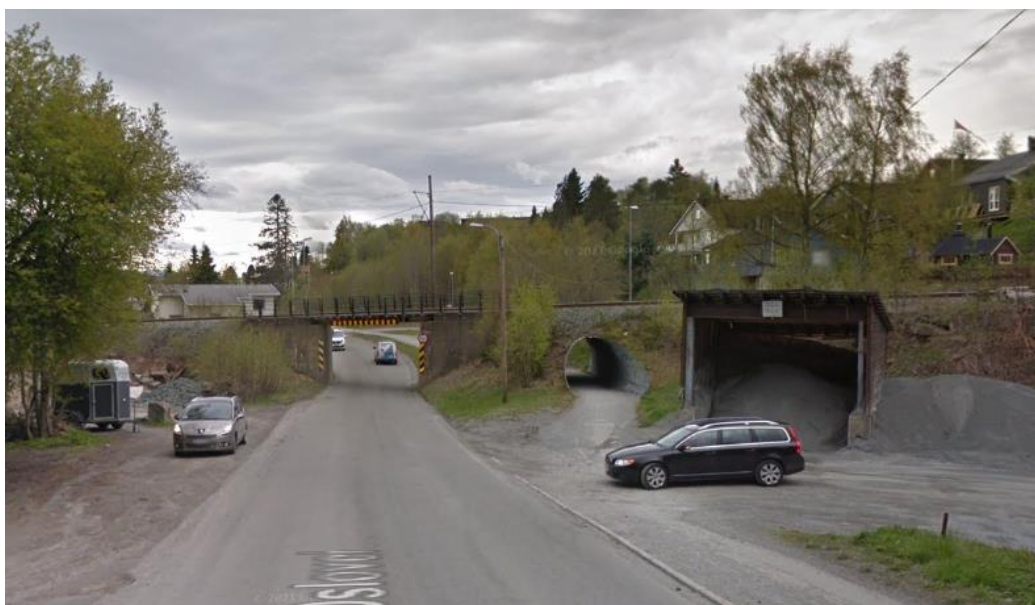
Figur 78: Dagens situasjon inn mot trikkebrua og kulvert (Svalbardrør) for gang- og sykkelvegen. Til høyre i bildet ser vi deler av kommunens gruslager. Vegbanen innsnevres under brua og makshøyde er 3,8 m
