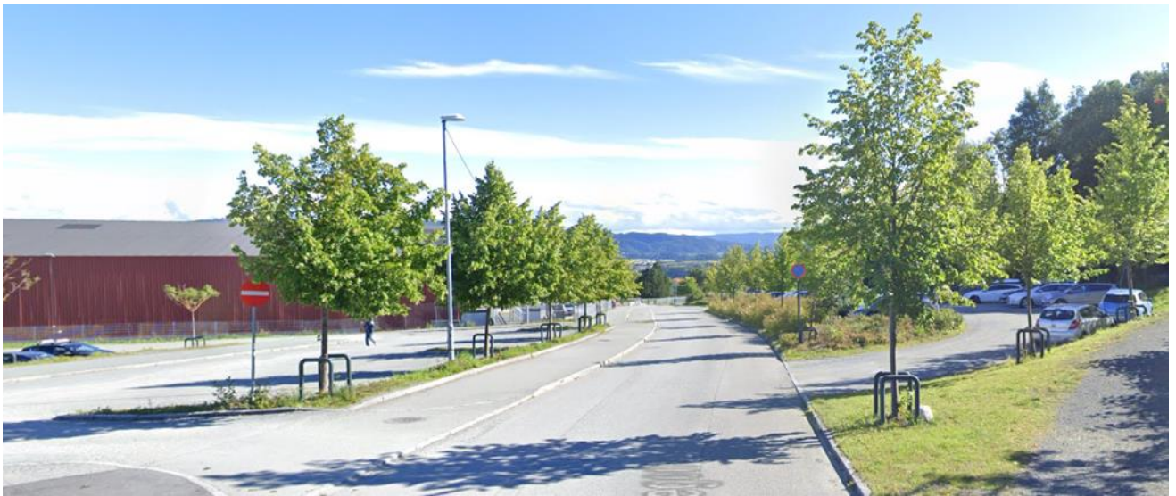
Figur 146: Dalgårdvegen ved idrettsanlegget med ensidig fortau og store parkeringsplasser på begge sider av vegen
