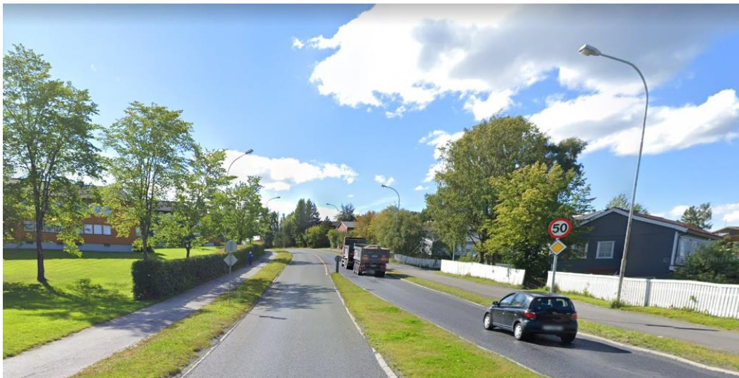
Figur 4: Utleirvegen mot sør. Viser tosidig gang- og sykkelveg.
