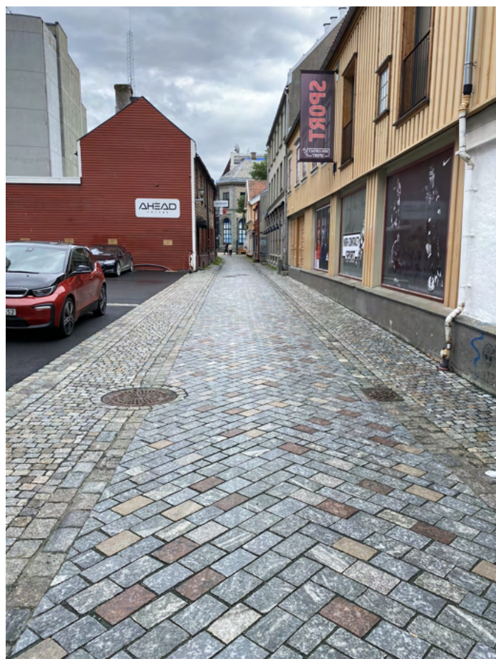
Delen av Sommerveita som er ferdig oppgradert.
