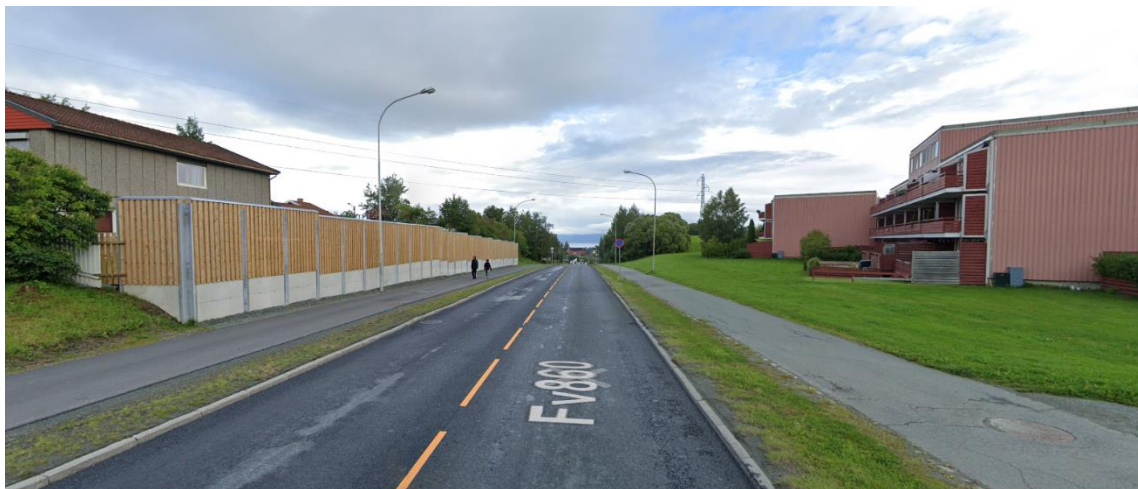
Figur 29 Eksisterende støyskjerm på motsatt side av veggen ved Utleirtunet 2-6. Det må sikres at betongmuren ikke medfører refleksjonsbidrag mot andre sida av veggen.
