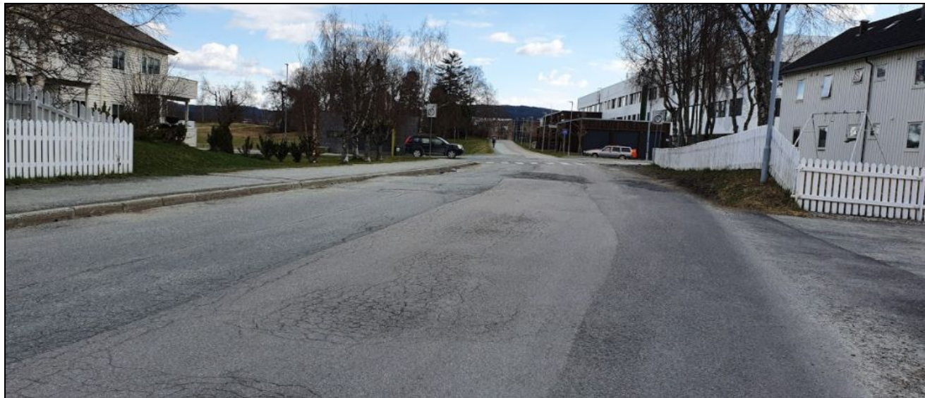
Figur 6 Foto strekningen mellom Paul Fjermstads veg og Harald Bothners veg, sett mot Harald Bothners veg ( Foto Trondheim kommune)
