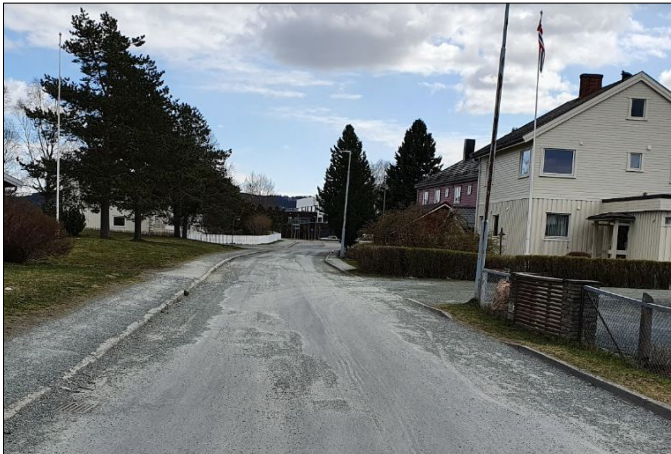
Figur 5 Foto strekningen mellom Kong Øysteins veg og Paul Fjermstads veg, sett mot Paul Fjermstads veg ( Foto Trondheim kommune)
