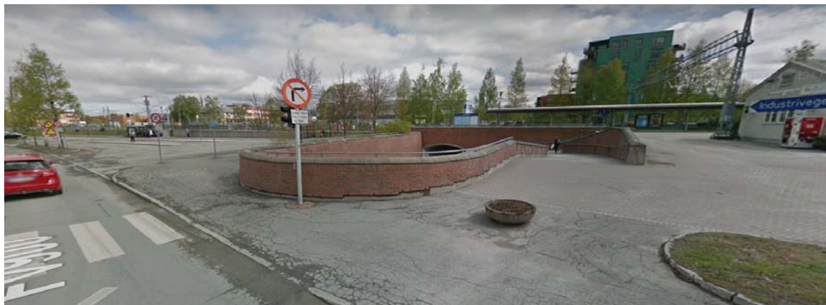
Undergang Heimdal stasjon, vestsiden- før ny stasjonsbygning ble oppført
