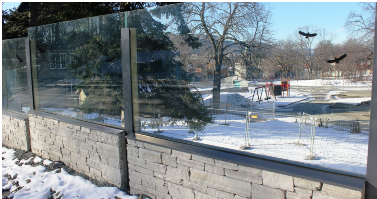
Deler av støyskjermen mot Singsaker skole- og barnehage er gjennomsiktig og dekorert med fugler i silhuett.
