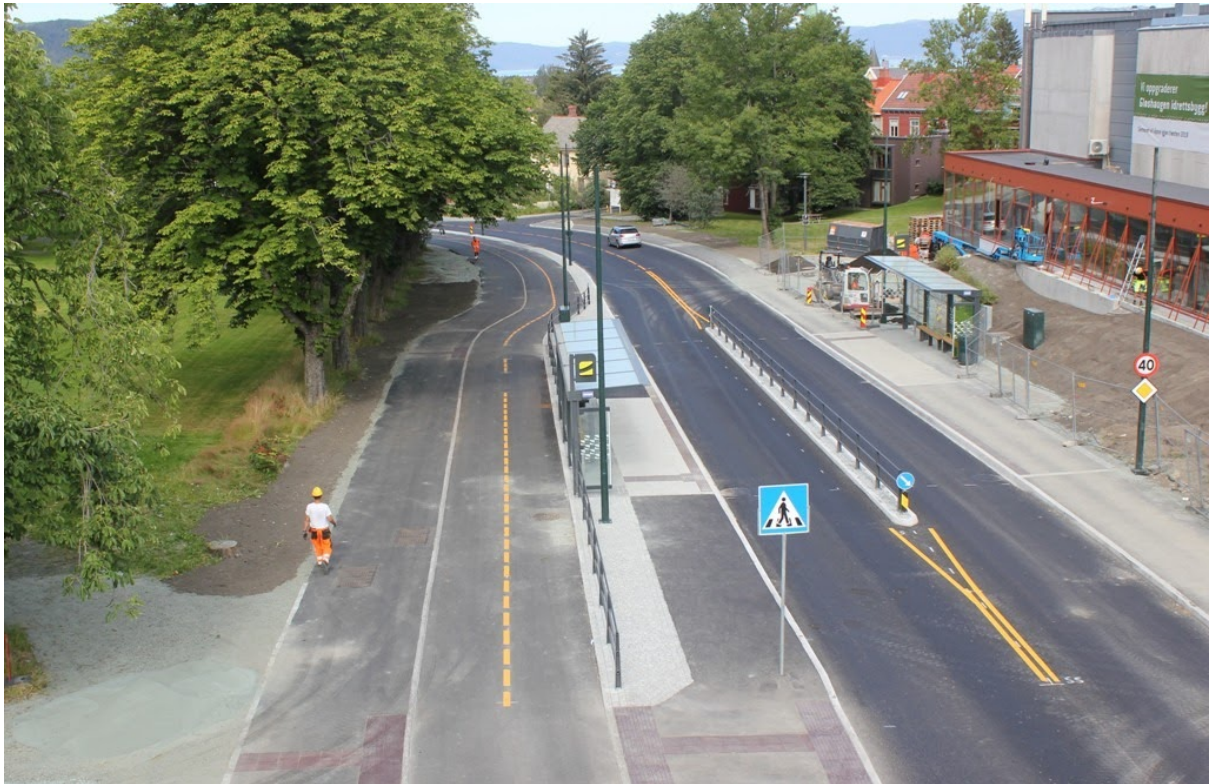
Bildet viser tiltaket ved Idrettsbygget NTNU
