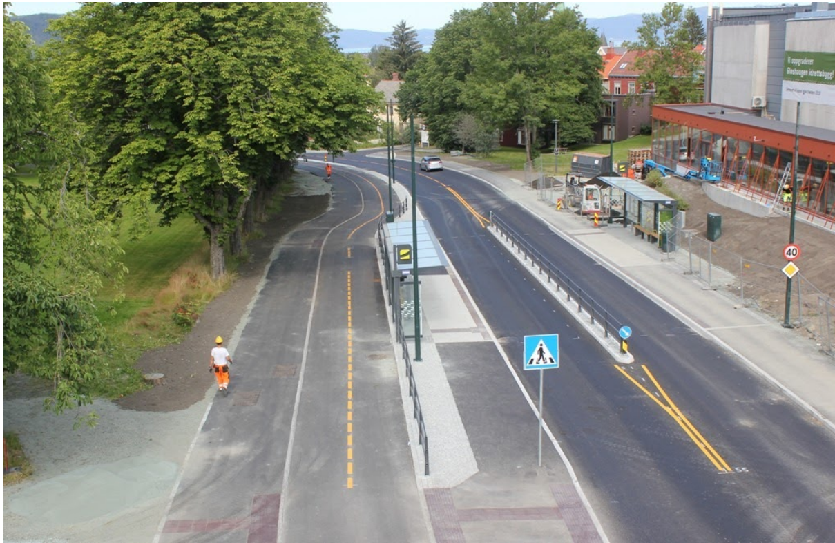
Bildet viser tiltaket ved Idrettsbygget NTNU
