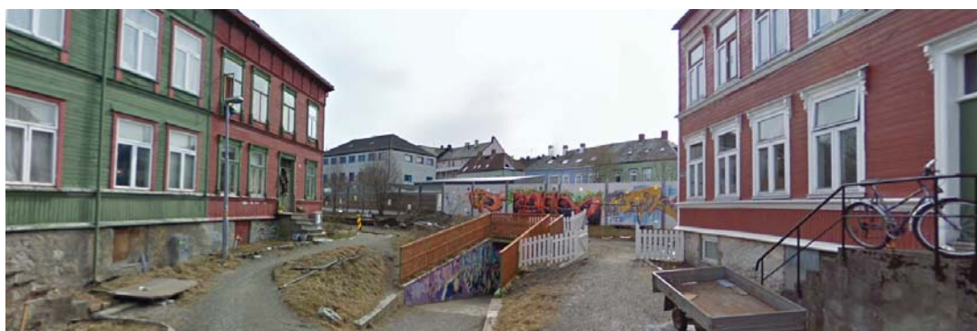
Undergangen sett fra nordsiden av jernbanen
