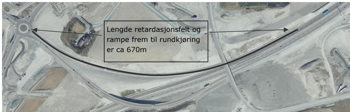
Figur 3 Rampe fra E6 fra Trondheim 2019
