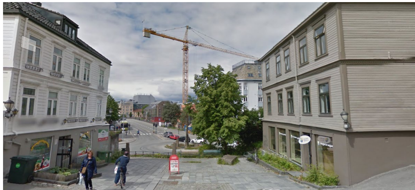
Området mellom Bakkegata og Bakke bru kan få bedre sammenheng i framtiden. Kilde: GoogleStreetView
