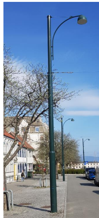
Figur 1 - Strekkmast i Tordenskiolds gate
