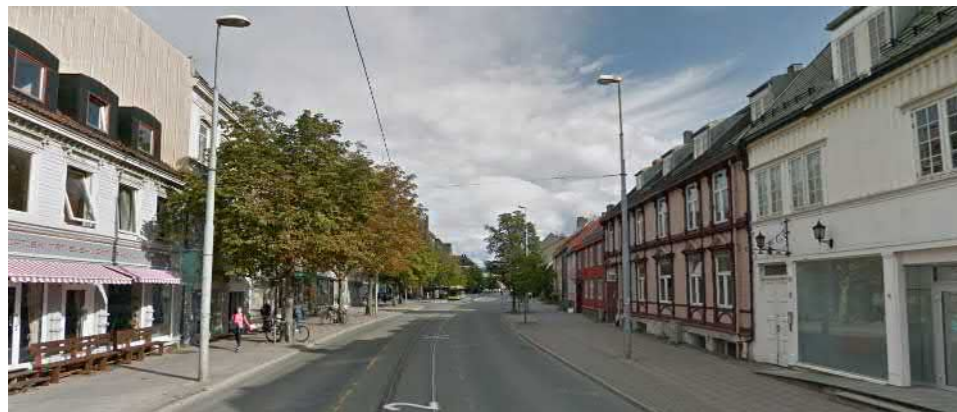
Figur 81: Dagens situasjon. Kilde: Google streeview
