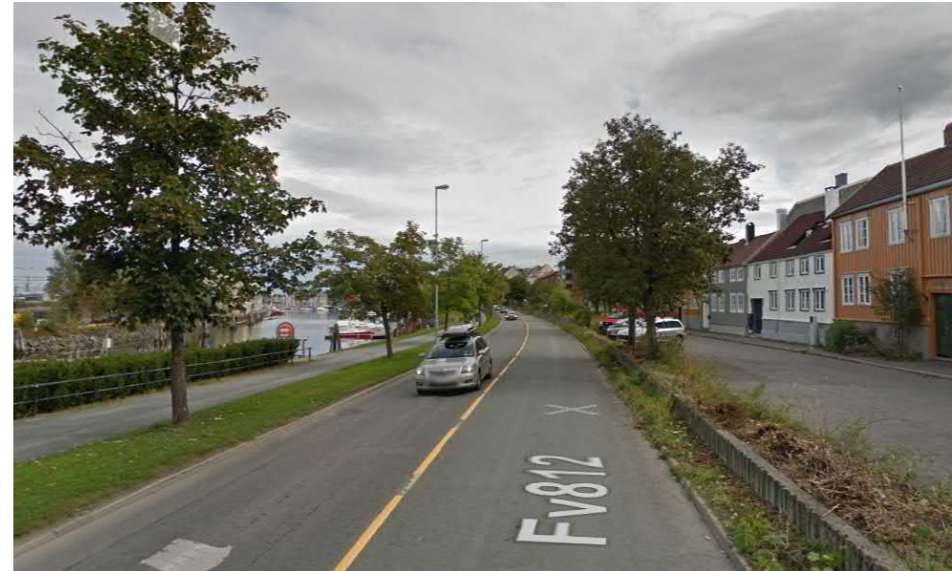
Figur 21: Sandgata. Kilde: Google Streetview
