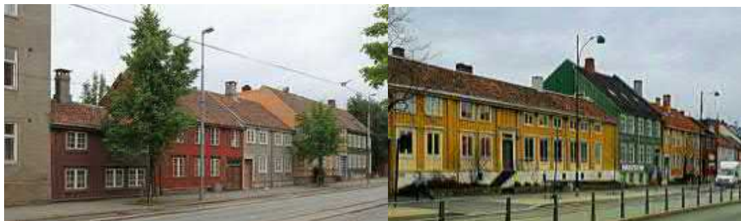
Trondheims eldste trehusbebyggelse: 1: Hospitalsløkkan på nordsiden av Kongens gate og vest for Hospitalet. Her har bebyggelsen aldri brent. Det lille brunmalte huset er reist før år 1700. 2: Kongens gates trehusbebyggelse på Kalvskinnsiden. Deler av det okermalte huset lengst til venstre i bildet er eldre enn bybrannen i 1681.
