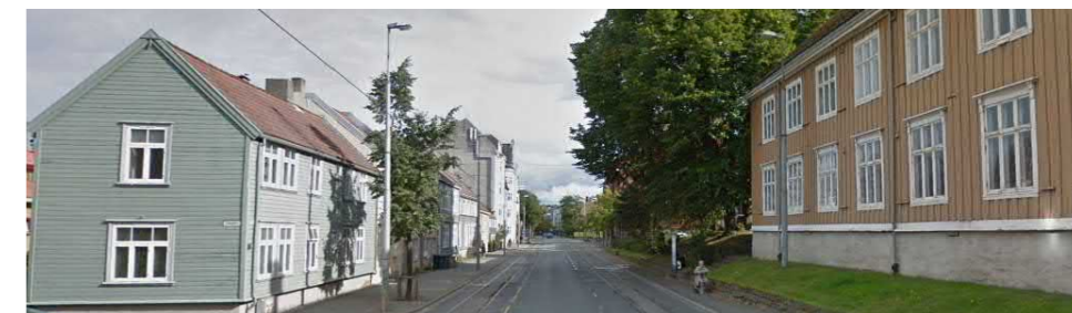
Figur 69: Strekningens vestlige del. Kilde: Street view, Google Maps
