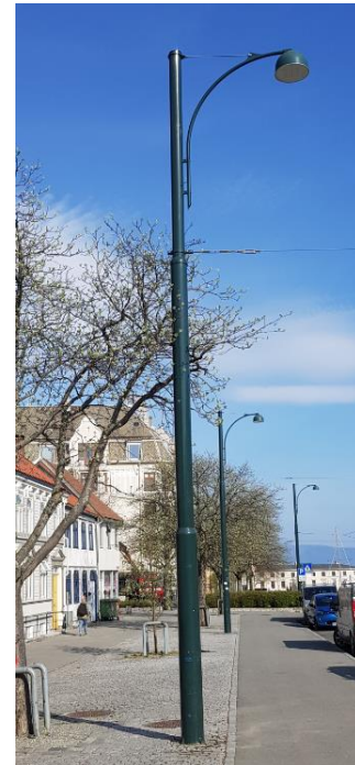
Figur 50 Strekkmast i Tordenskiolds gate
