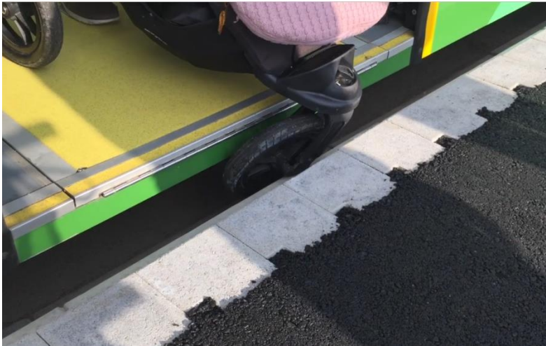
Figur 12 Hjul på barnevogn setter seg fast mellom buss og holdeplass. Foto: Statens vegvesen
