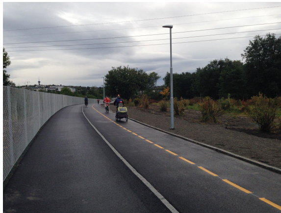
Sykkelveg på Stavne. Foto: Miljøpakken
