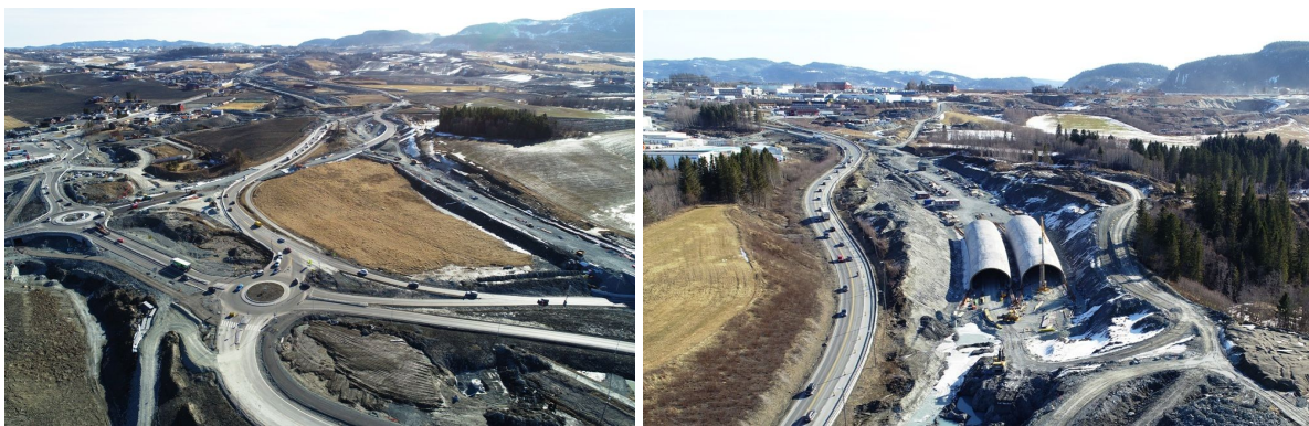
E6 Sør, Klett og støpt viltovergang ved Storlersbakken. Foto: Vegard Thorvaldsen, SVV.
