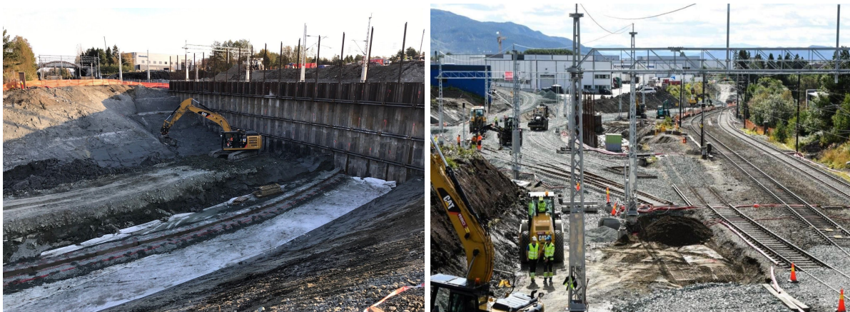
Byggegrøp før støping av kulvert, foto: HR Prosjekt AS. Interims spor, foto: Miljøpakken.
