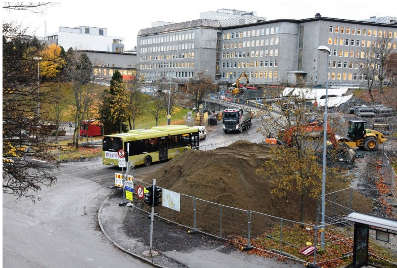
Høgskoleringen i arbeid. Foto: Miljøpakken
