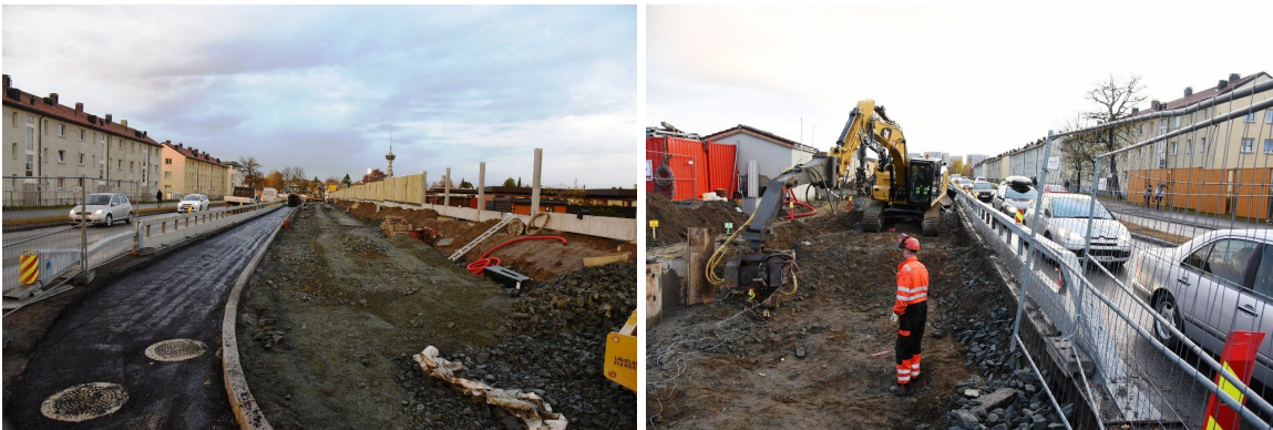
Jonsvannsveien i arbeid. Foto: Miljøpakken
