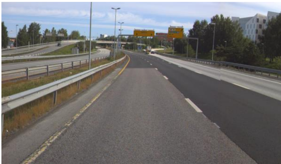
Figur 10 Sluppenkrysset er aktuelt for en mindre ombygging
