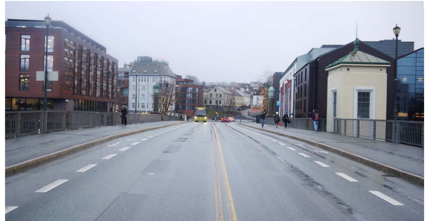
Figur 24 Dagens gatesnitt over Bakke bro – omformet i forbindelse med prøveprosjektet i Olav Tryggvassons gate til tofelts vei med sykkelstier og fortausbredde på totalt 16,3 m. Foto: Asplan Viak
