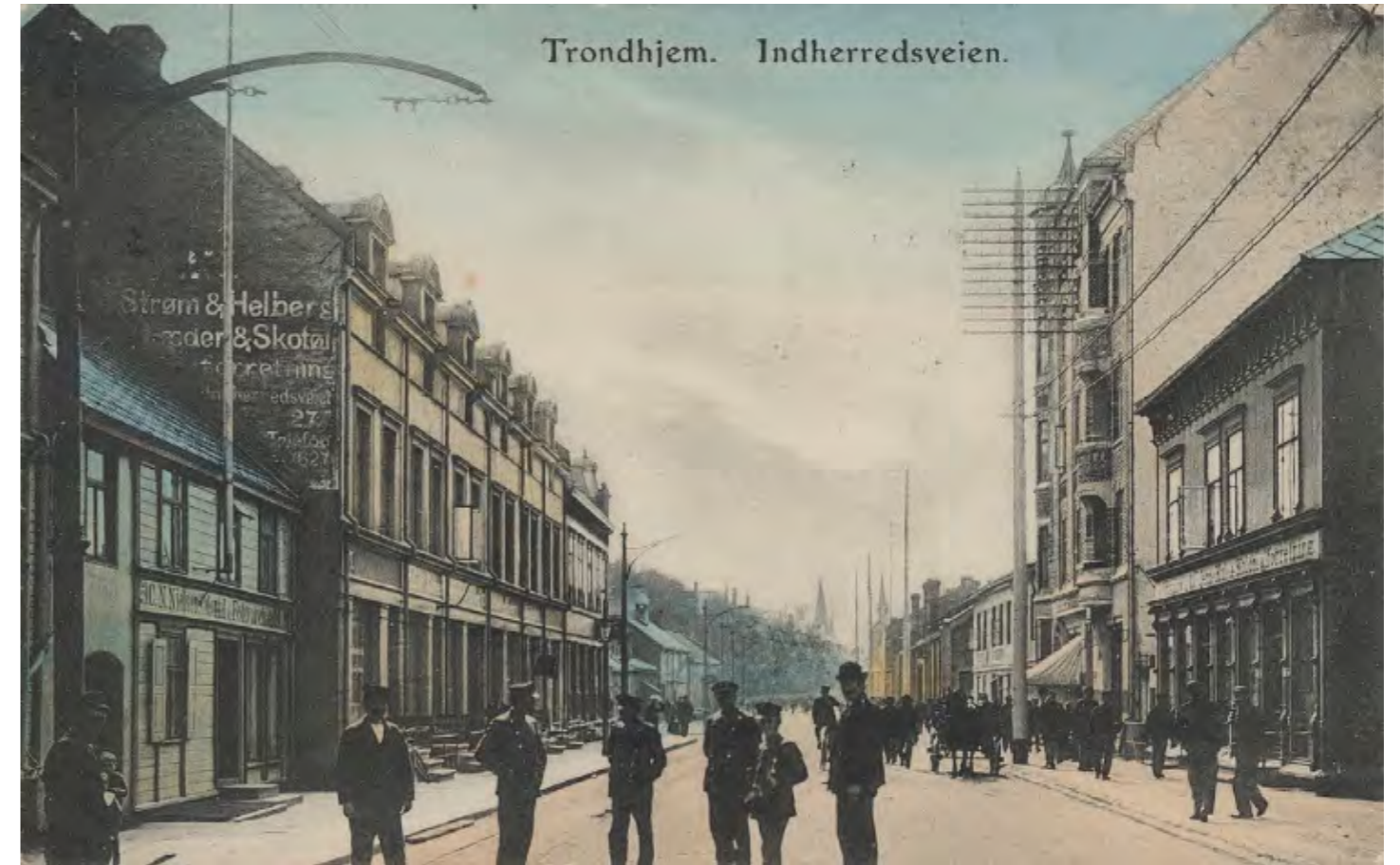
Figur 1 Håndkolorert postkort fra Innherredsveien sett fra Bassengbakken mot Bakke kirke, trolig starten av 1900-tallet. Kilde: Trondheims byarkiv
