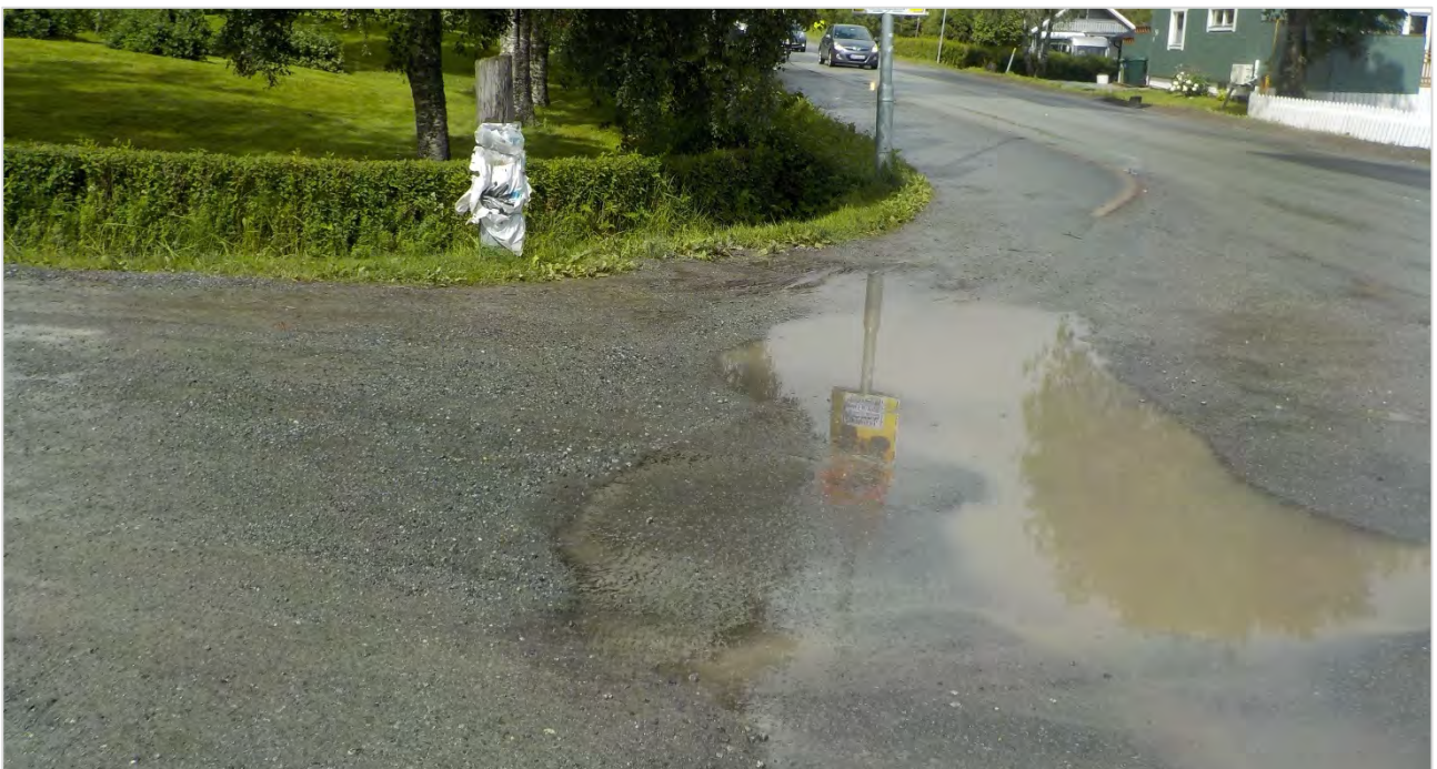
Figur 2-4 Overvann i krysset Holtvegen/Søbstadvegen
