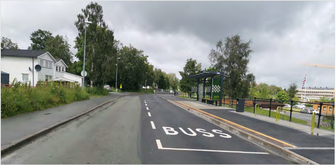
Figur 2-3 Ny metrobussholdeplass for Skyttervegen (sett mot nord), med StatPed nede til høyre i bildet (Norconsult juli 2019).
