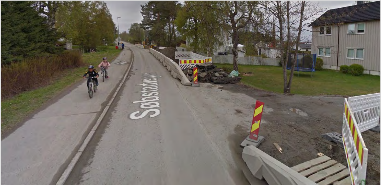
Figur 6-1 Bilde fra google maps – anleggsarbeid i mai 2019 hvor det er gravd hull ved Søbstadvegen for gjennomføring av no-dig-løsning for vann
