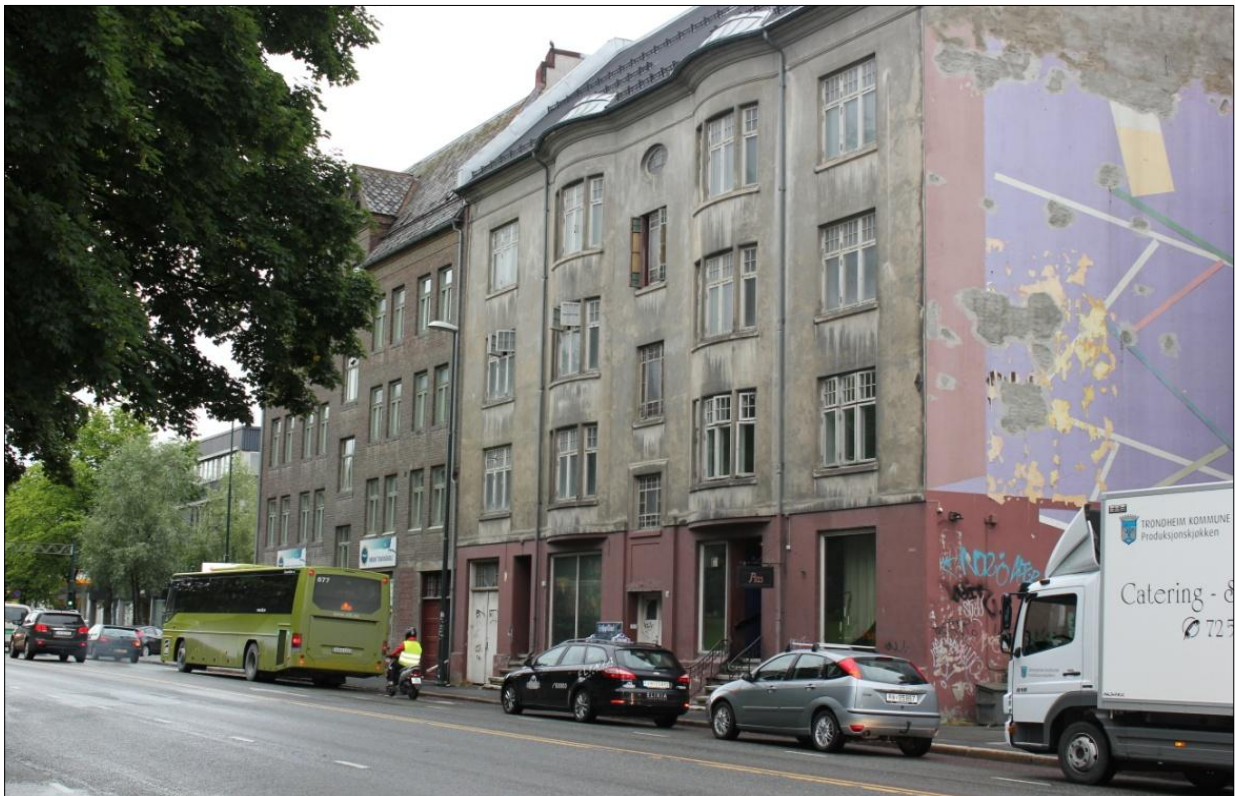
Elgeseter gate 4 og 6 ble bygget da regulert bredde var 18 meter. Selv om bygningene er verneverdige i seg selv, legger de store begrensninger for utnyttelsen av Elgeseter gate, og det foreslås å åpne for at gårdene kan rives.
