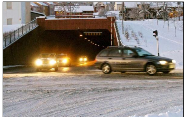
Tunnelåpning bytunnel i Tromsø
