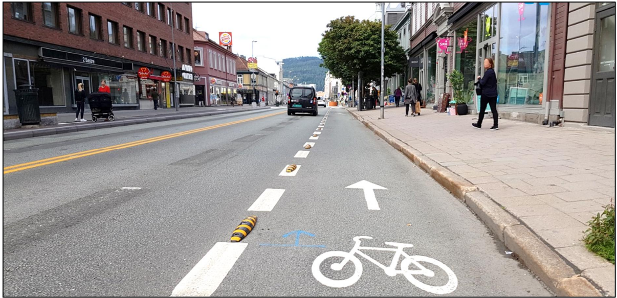
Figur 11: Sykkelfelt i Olav Tryggvasons gate etter tiltak
