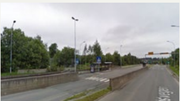
Husbytn - adkomst til stasjon via undergang.
