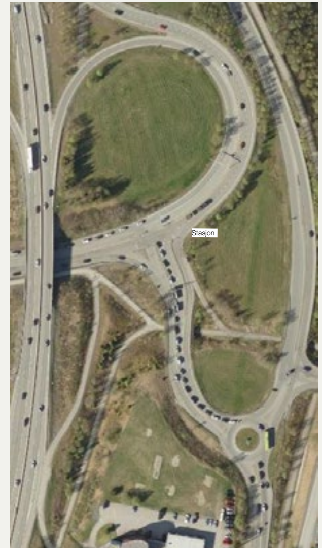
Tonstadkrysset. En stor trafikkmaskin som oppleves som en barriere for forgjengere.
