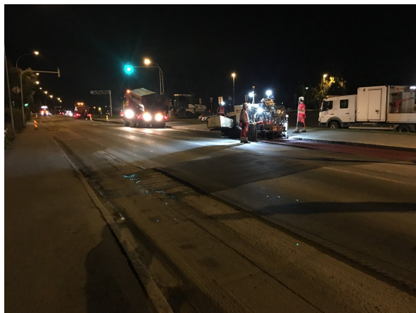
Nattarbeid i Kong Øysteins veg. Foto: Odd Nygård, Statens vegvesen.
