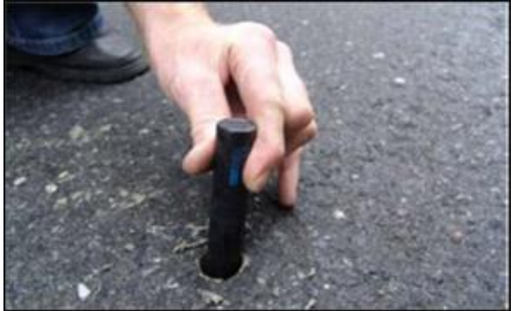
Figur 52. RFID- brikke som monteres direkte i asfaltdekke
