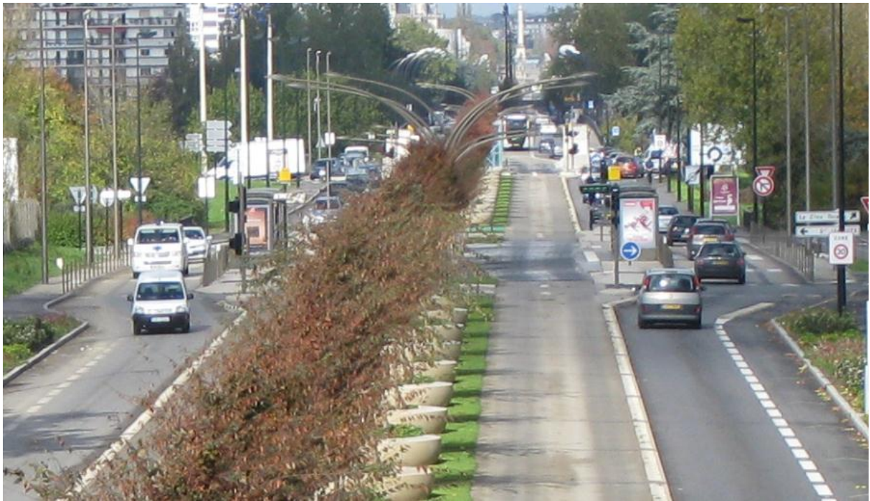
Figur 17. Midtstilt kollektivfelt, Nantes Frankrike. Foto Anders Dalen, Statens vegvesen
