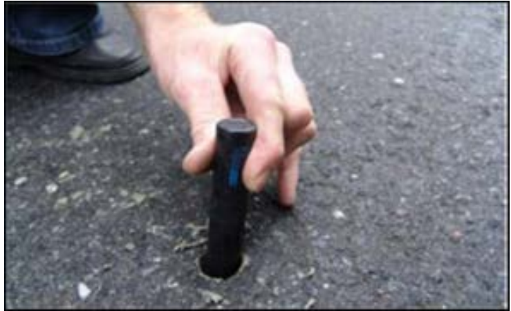
Figur 47. RFID- brikke som monteres direkte i asfaltdekke
