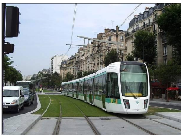
Spesiell trasé dobbelspor, T3 i Paris
