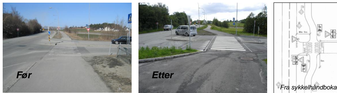
Figur 17 Tiltak hvor syklisterne gis prioritet ved kryssing av veg. Eksempel fra Skovgård.
