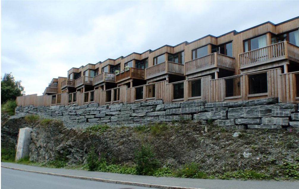
Figur 7: Robust støyskjerm med kombinasjon av stein, tre og pleksiglass som er godt tilpasset bebyggelsen.
