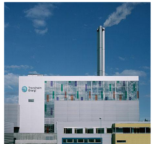
Bilde: Den nye varmesentralen på Heimdal. Foto: Trondheim Energi Fjernvarme
